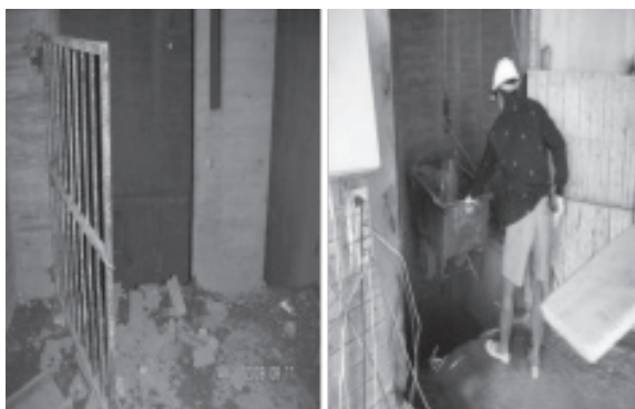
圖 2 電梯開口作業
